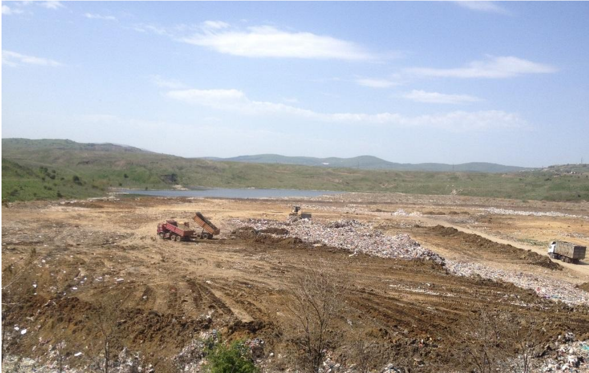
Pokrivanje otpada sa slojem zemljišta u sanitarnoj deponiji u Mirašu
